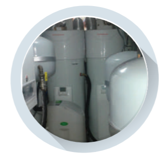
Les Roches « Benslimane » Plancher chauffant haudière à condensation Chauffe-eau solaire circuit forcé
