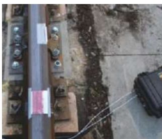
Mesure de charges sur rails
