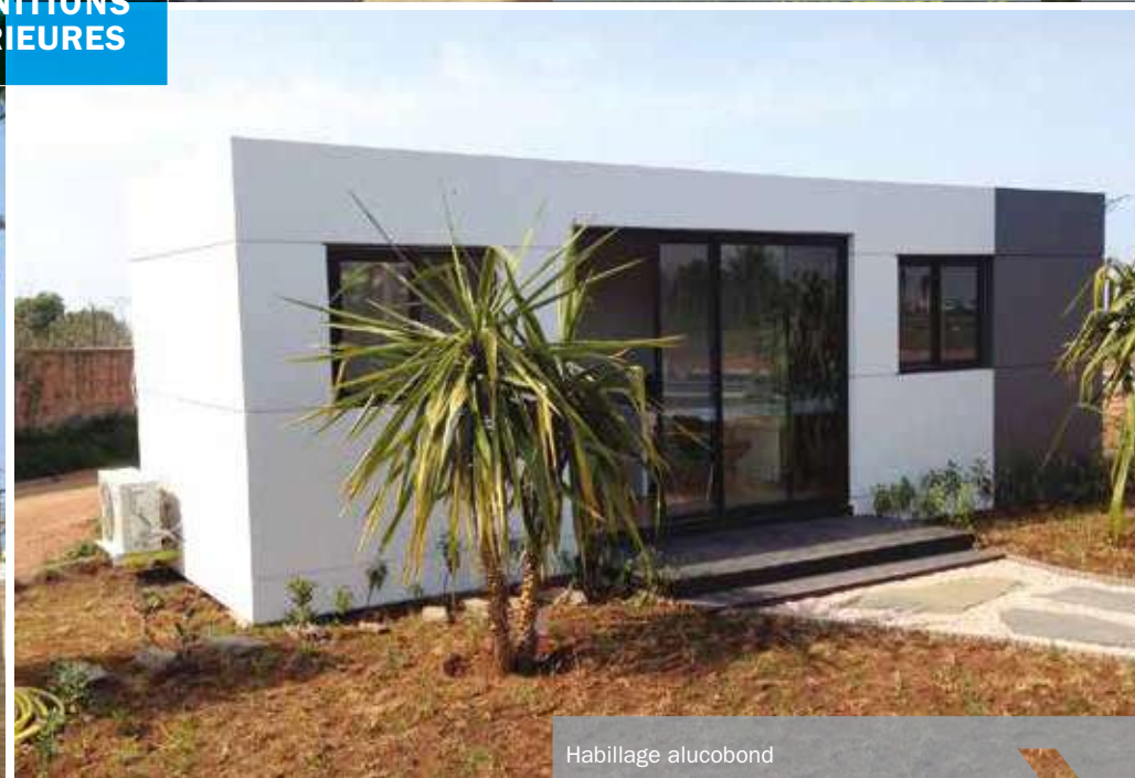
Habillage alucobond et carrelage céramique
