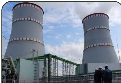
CENTRALE NUCLÉAIRE D'AKKUYU
